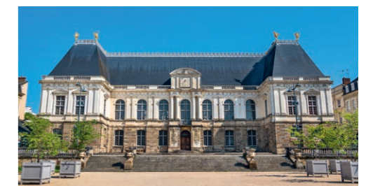
LE PARLEMENT DE BRETAGNE RUE HOCHÉ
